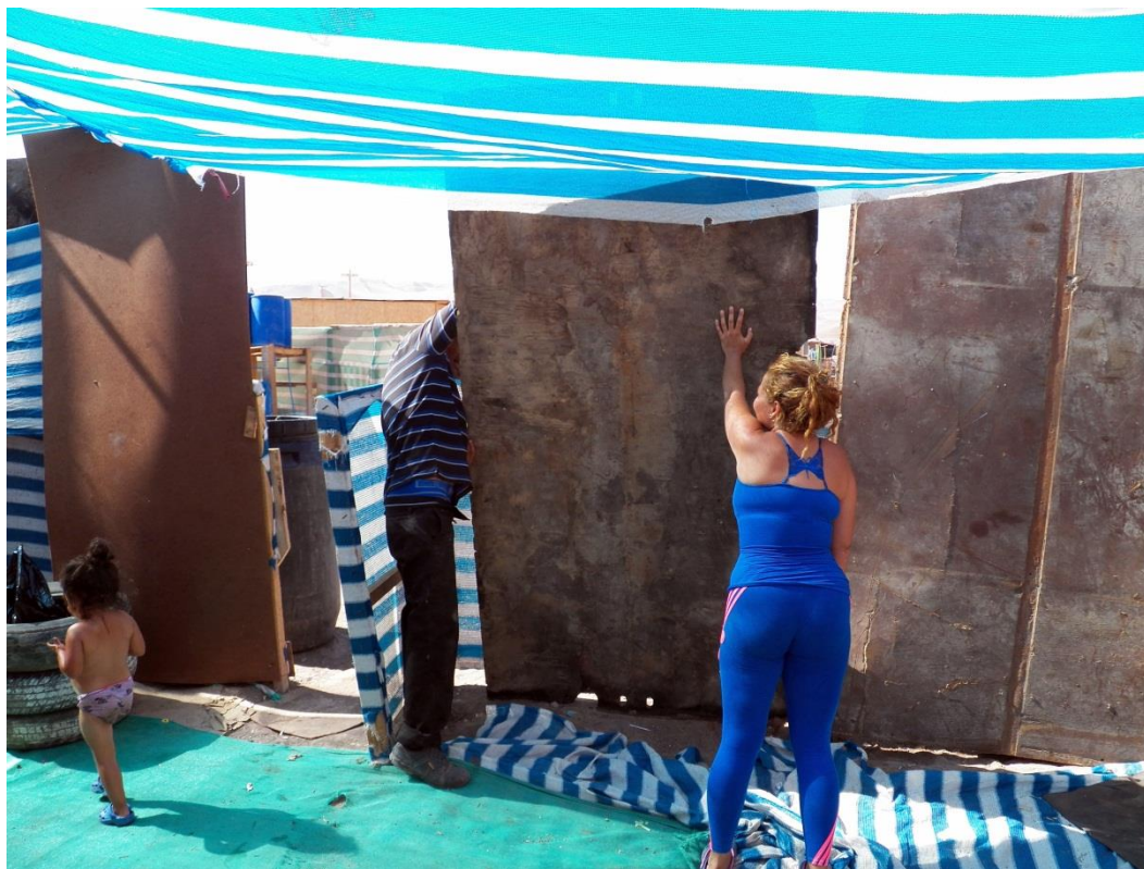
Figura 11: Vecino ayudando a construir un muro con paneles reciclados en el perímetro frontal del sitio. Fuente: registro fotográfico propio.
