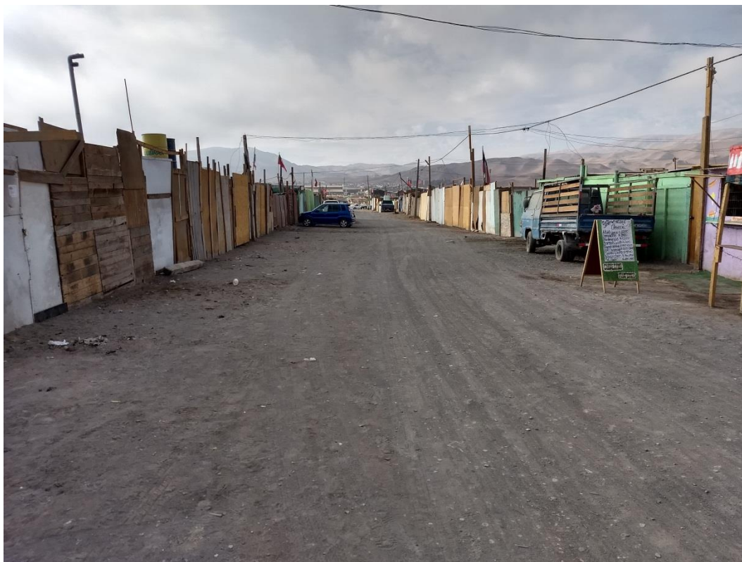
Figura 4: Casas de fachada continúa en comité San Lorenzo. Fuente: registro fotográfico propio.
