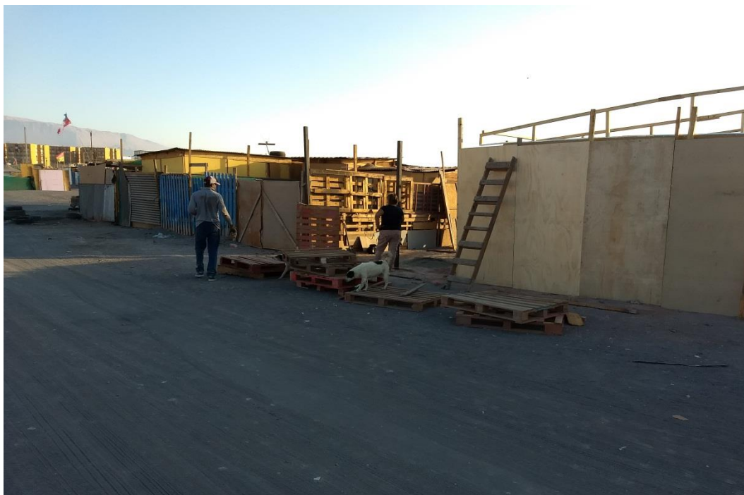
Figura 9: Construcción de casa en el comité Integración. Fuente: registro fotográfico propio.
